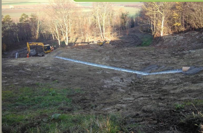
Pose de cunettes métalliques pour l'évacuation des eaux
