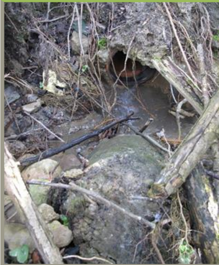
Ruissellement en direction du glissement
