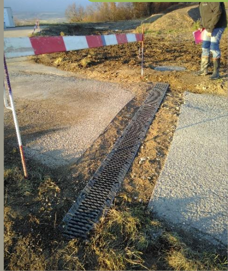
Pose de cunettes métalliques pour l'évacuation des eaux
