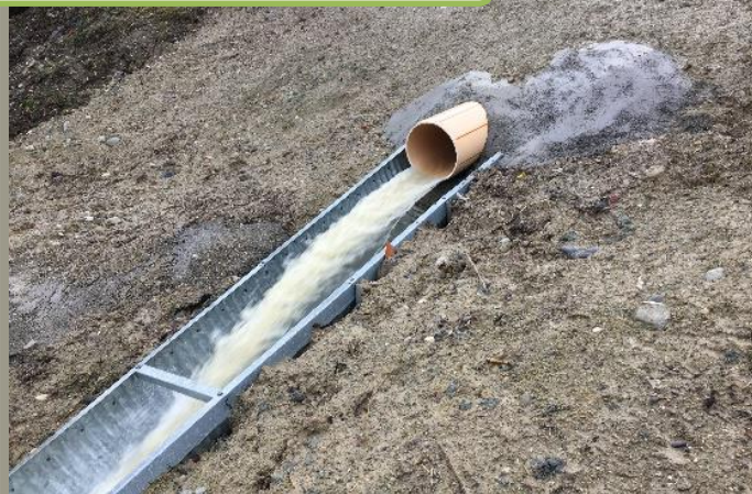
Pose de cunettes métalliques pour l'évacuation des eaux
