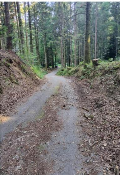
Des renvois d'eau ont été posés sur les secteurs les plus en pente et une cunette de récolte des eaux a été réalisée pour le Chemin Creux car étant encaissé, il était impossible d'y mettre des renvois d'eau.
